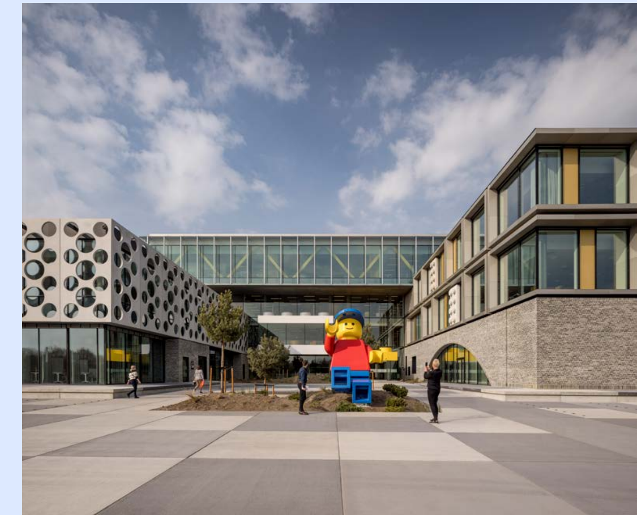
LEGO Groups fokus på lek har fått sätta prägeln på deras största bygge hittills. De åtta olika huskropparna är sammankopplade och möjliggör för flexibla och varierande miljöer.
